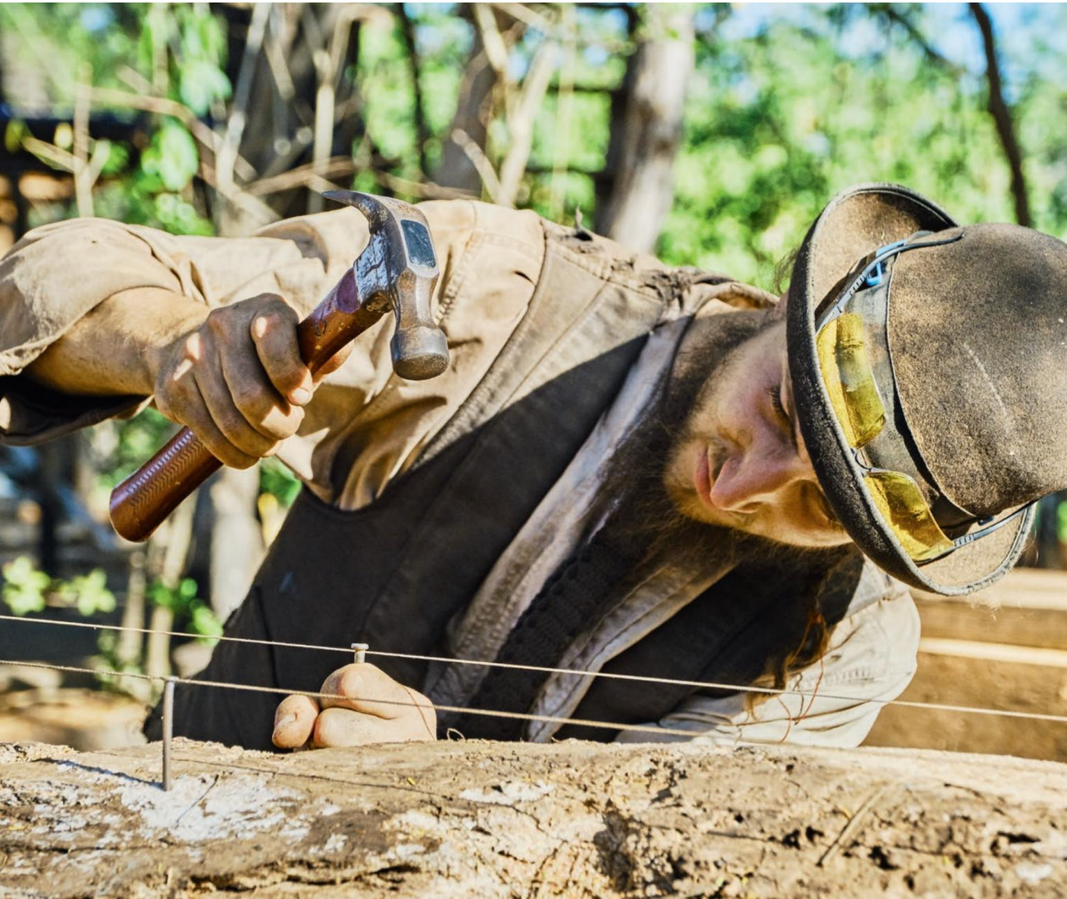
Zimmermann Roland präpariert einen Stamm, um die Motorsäge möglichst horizontal durch das Holz führen zu können. Nicht die Geschwindigkeit zählt beim Sägen, sondern die Exaktheit. Tamarindenholz hat eine höhere Dichte als Wasser und ist extrem mühsam zu sägen
